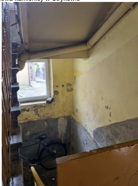
Fotografia 23 Klatka schodowa kamienicy w Strykowie
