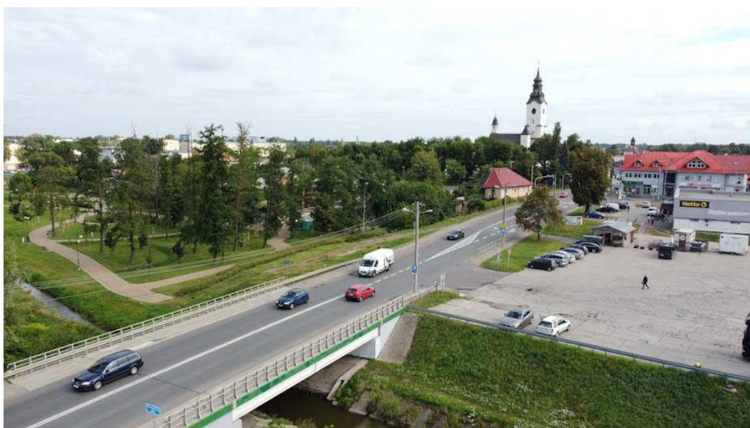
Fotografia 8 Droga krajowa nr 14 w Strykowie
