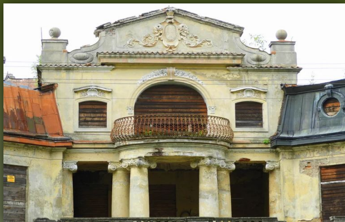
Elewacja wschodnia, piętrowa z szerokim tarasem, stan z 2018r.
